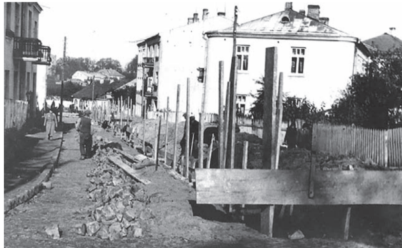
Закладання водогону на теперешній вулиці Бойка в кінці 1930-х років
