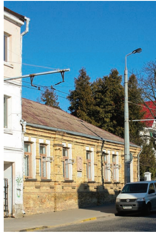
комбінацій з цегли. Будинки цегляного стилю ніколи не штукатурять. Цей корпус Луцької української гімназії зроблено з цегли місцевого заводу Абрама Глікля «Лучанин». На фасаді можна знайти цеглу з відповідним написом.
