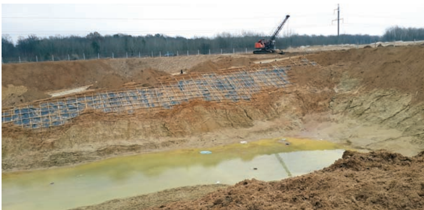
Так виглядає котлован під нове сміттєзвалище
